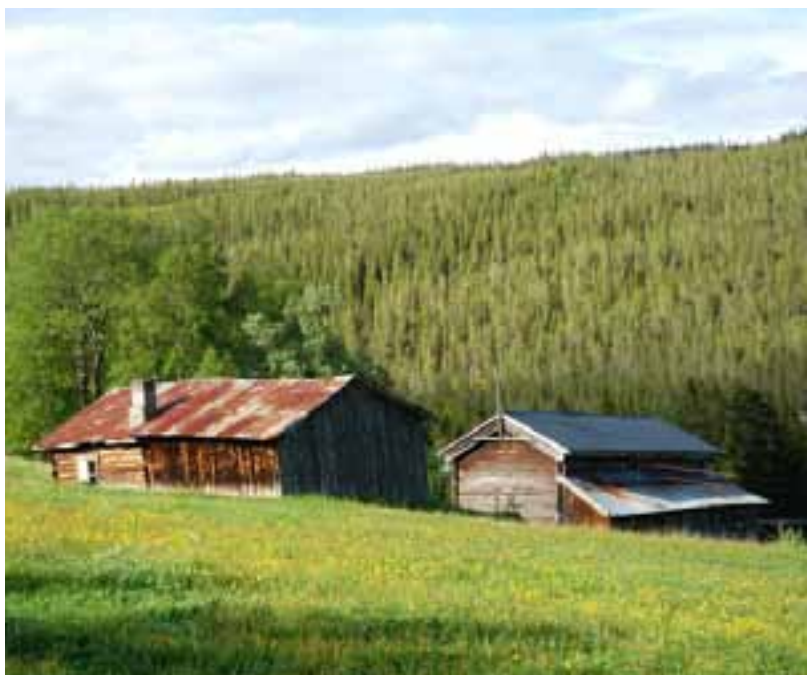
Gamle, fraflytta hus på gårdsbruk. Trysil, Hedmark.
