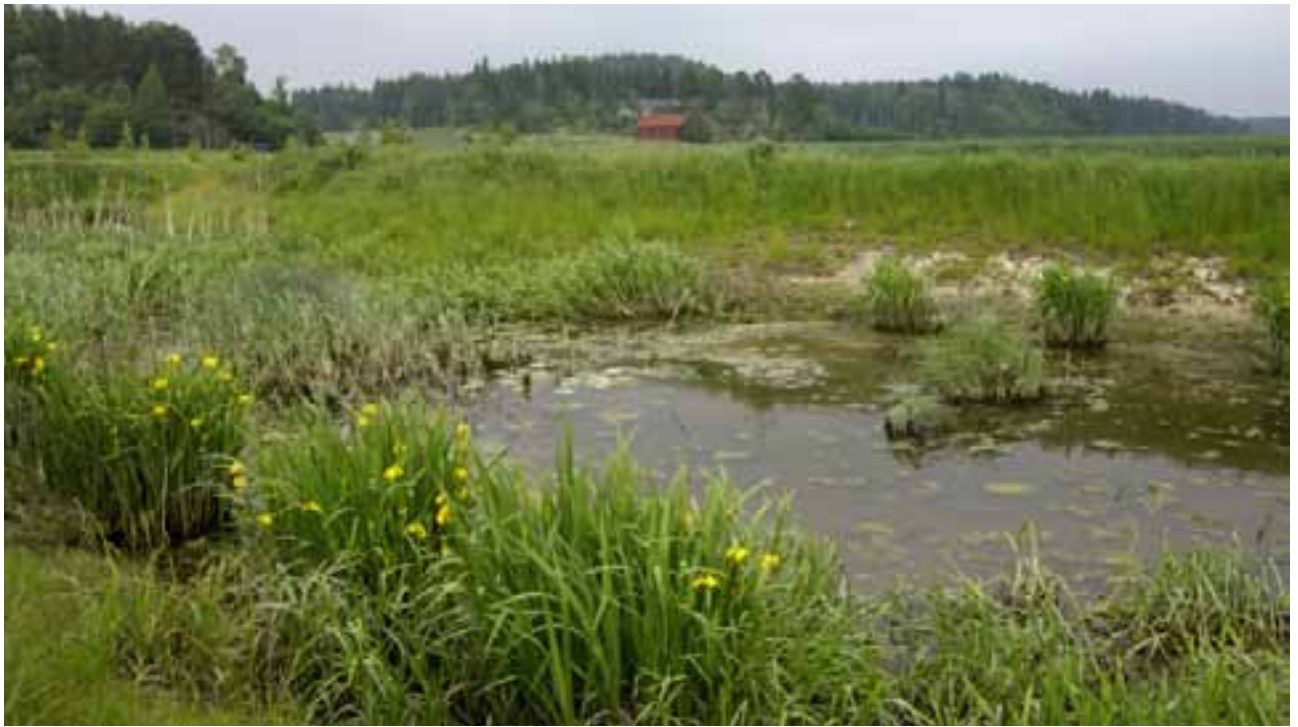
Konstruert fangdam for å hindre avrenning av næringsstoffer fra dyrka mark og ut i innsjøer. Vannsjø, Østfold.
